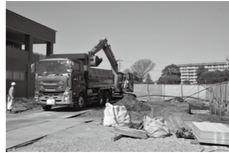
▲造成工事が進む建築予定地
